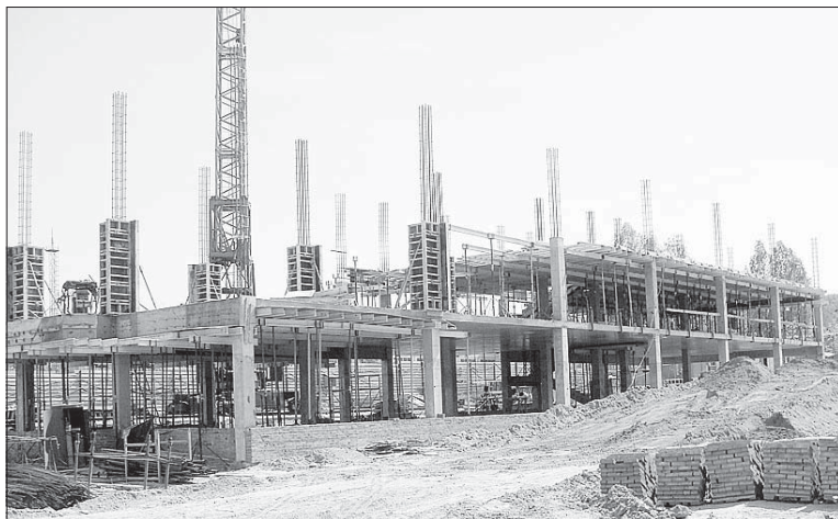
Так лабораторный корпус технопарка выглядел в мае. С тех пор на стройке ничего не изменилось.
