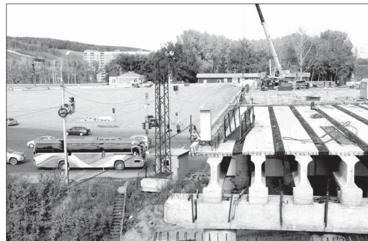
Здесь возведены все опоры путепровода через Бердское шоссе, свайное основание и насадки железобетонного моста, закончен монтаж пролетных строений. Сейчас дорожники производят монтаж металлической водопропускной трубы на съезде в Первомайский район, ведут переустройство канализационных коллекторов. Запустить автомобильное движение по двухуровневой транспортной развязке планируется в ноябре текущего года.
