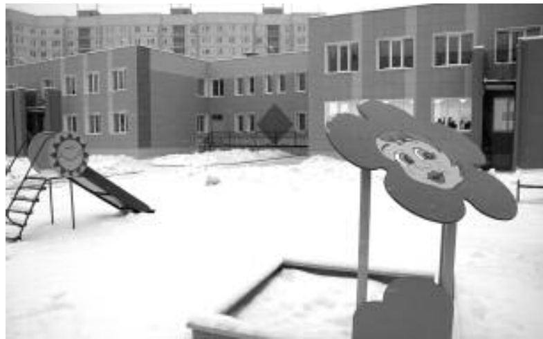
Детский сад от компании «Энергомонтаж» примет ребят в январе.
