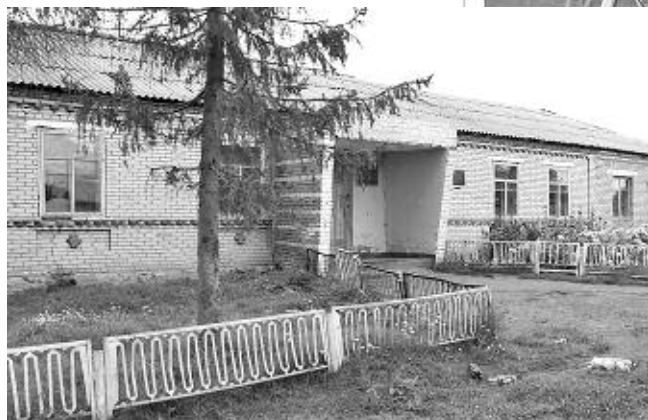
Старое здание школы.
