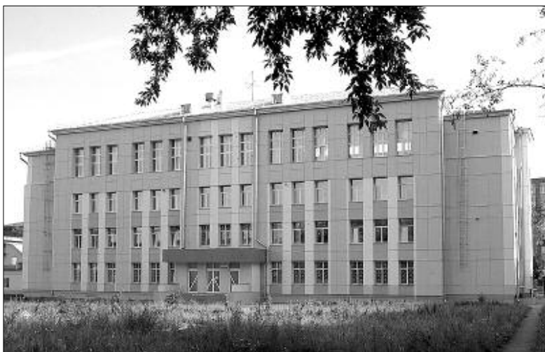
Здание школы-интерната в Бердске.
