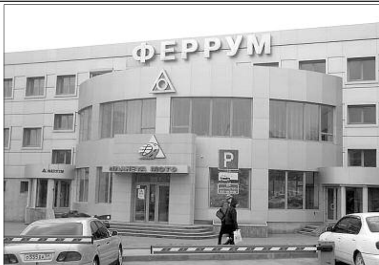
В этом здании компания установила общеобменную вентиляцию и систему кондиционирования.
