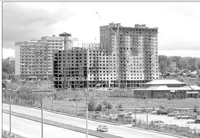
Жилой массив «Военная горка» в центре Новосибирска, 1-й и 2-й пусковые комплексы. Престижное жилье.
