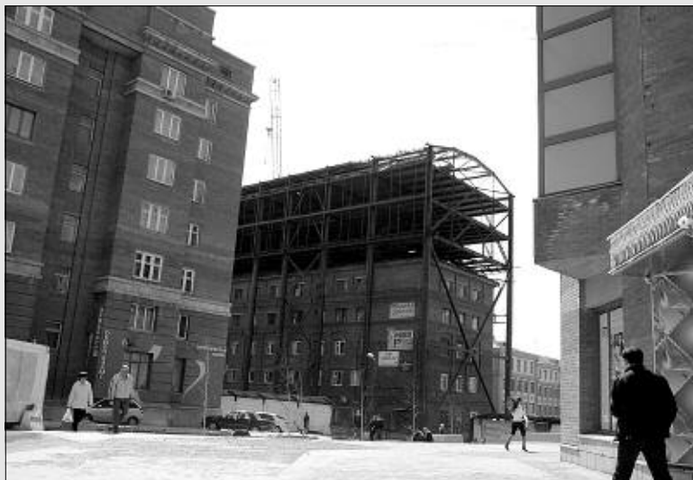
Металлический каркас здания смонтирован в мае 2005 г.
