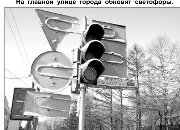
Традиционные лампы на этих объектах горят тускло и днем достаточно трудно сразу определить их цвет, что не-редко приводит к аварийным ситуациям. Ламповые светофоры уступят свое место светодиодным: до конца года современные «авторегулировщики» планируется заменить на 16 перекрестках Новосибирска.
