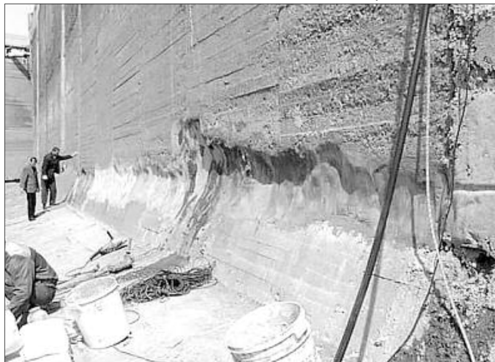
Ремонт первой шлюзовой камеры Новосибирского района гидросооружений.
