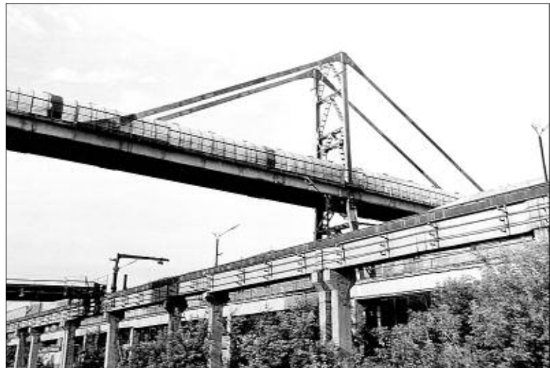
Галерея подачи заполнителей ДСК-1.
