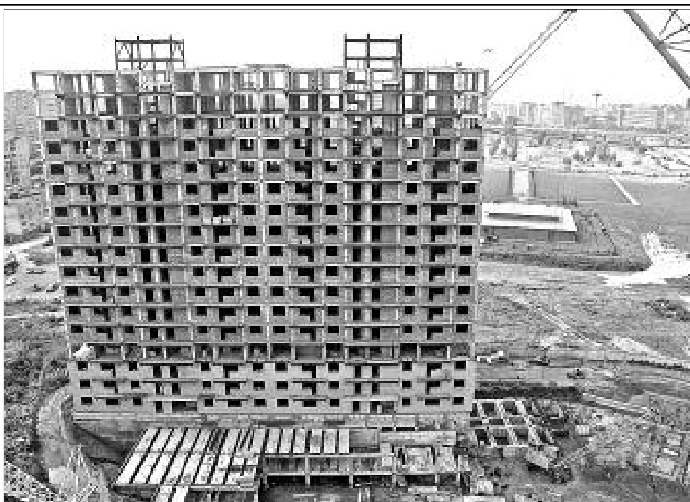
Строящийся жилмассив «Военная горка».
