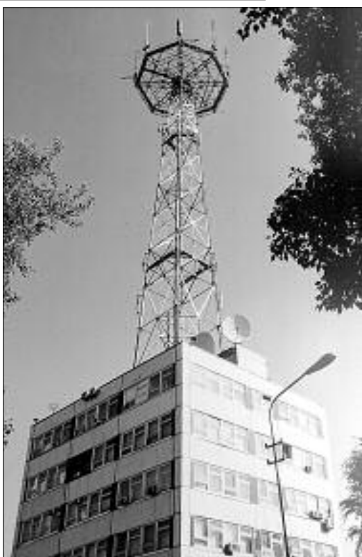
Башня системы «Алтай» на ул. Выставочной.
