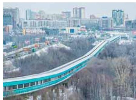
Новосибирские метропоезда пересекают Обь по самому длинному крытому мосту в мире. Кроме того, уникальна и его конструкция: при строительстве моста впервые была использована технология надвижки пролетов вместо установки с реки. Из-за сильных перепадов температур зимой мост сокращается, а летом растягивается на 50 см, в связи с чем на его опорах есть специальные ролики, по которым «катается» вся коробчатая конструкция.
