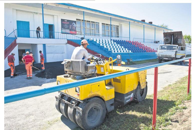
Перед реконструированной трибуной с пластиковыми креслами идёт укладка дорожного покрытия.
