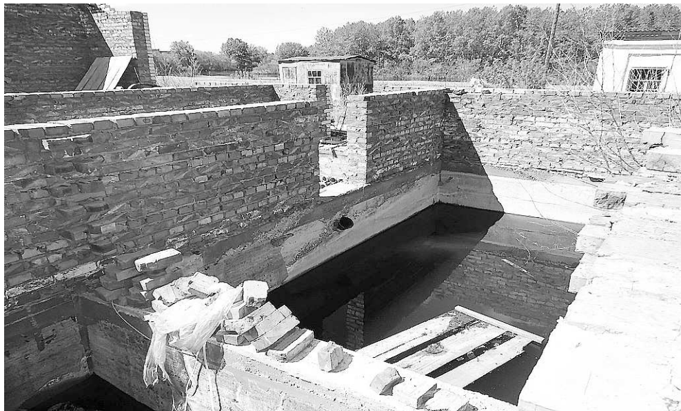
Работы на объекте не ведутся с декабря 2012 года.
