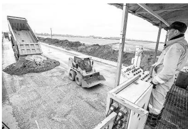
Качество бетона позволяет строить вечные дороги.
