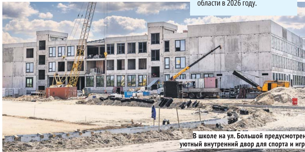
В здании на ул. Татьяны Снежиной уже просматривается будущая школа.
