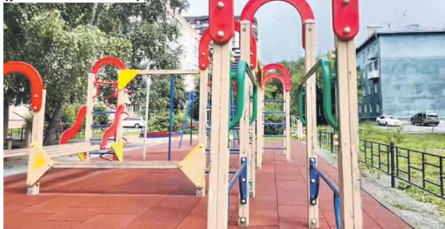
Установка детской игровой площадки (ул. Д. Давыдова, 1).
