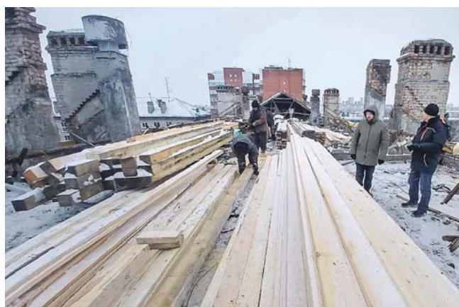
**Работа подрядной организации, которая занимается капитальным ремонтом крыши дома на улице Народная, 5, — на контроле у депутата.** Рабочие разобрали первую половину кровли, вывезли старые конструкции, завезли материал для новых конструктивных элементов и уже установили мауэрлат. В планах — до конца года закрыть эту половину и приступить к демонтажу оставшейся части.
