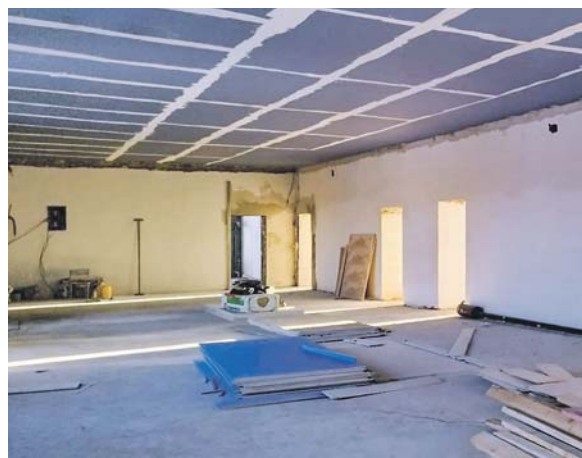
Завершение капитального ремонта в школе №147 планируется осенью 2025 года.
