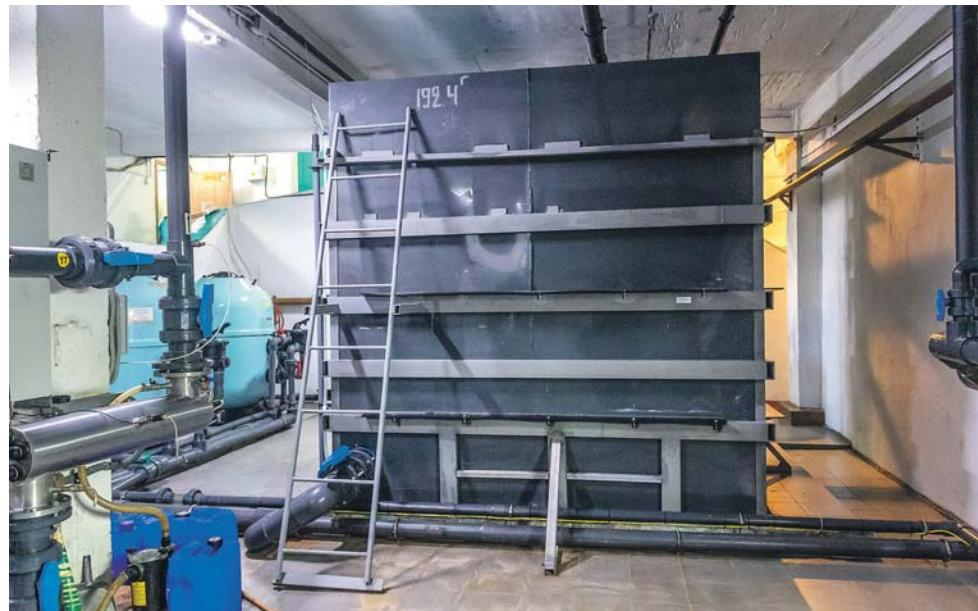
товки бассейна. Возникла острая необходимость заменить переливной бак. Ранее ёмкость была металлической, и постоянный контакт с водой и хлором не могли не сказаться на износе бака. В воде так или иначе оседали частицы ржавчины. Коррозия разрушала стенки установки, что приводило к постоянным протечкам. Нет ничего удивительного в том, что важный элемент бассейна, который ни разу не меняли с момента постройки объекта, был порядком изношен и практически непригоден для дальнейшей эксплуатации.
