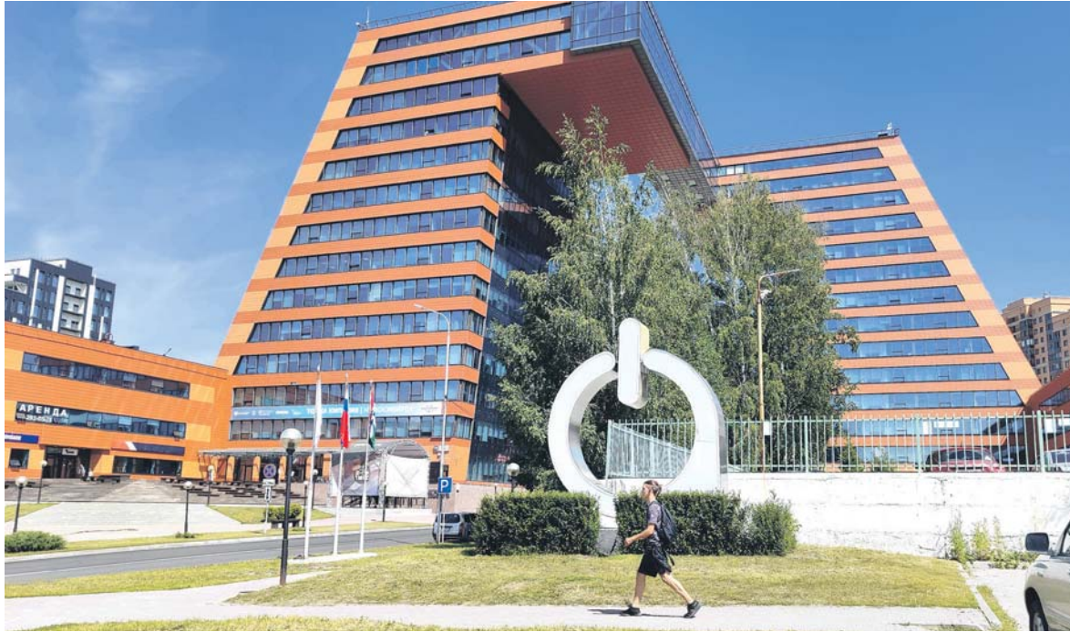
В ближайшие годы в Академпарке построят три новые площадки площадью более 100 тысяч «квадратов».
