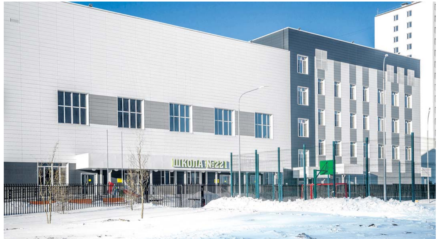
Школа на улице Забалуева в Новосибирске была построена по национальному проекту «Образование».
