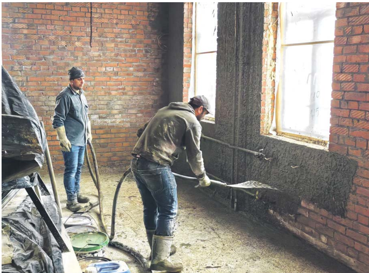
Строители приступили к внутренней отделке помещений и установке инженерных систем.
