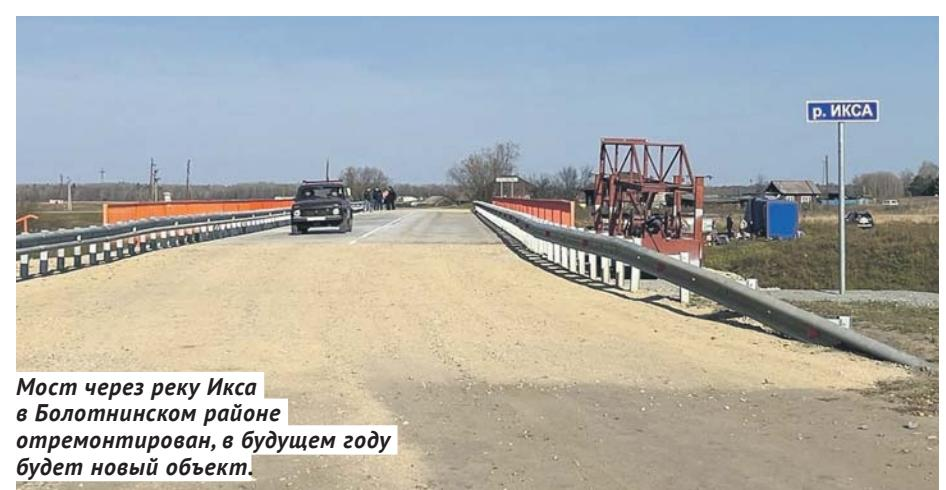
го пропуска паводковых вод. На мосту теперь новое цементно-бетонное дорожное покрытие, которое должно прослужить долго. По крайней мере, подрядчики дают восьмилетнюю гарантию, в течение которой любые дефекты в дорожном покрытии, гидроизоляции или барьерах ограждении будут исправляться силами строителей. А более 200 жителей деревни Кругликово теперь могут перемещаться через реку абсолютно безопасно.
