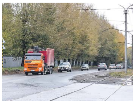
Расширение проспекта Дзержинского.
