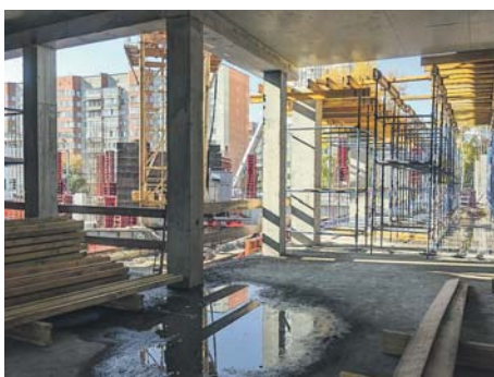
В здании школы №57 стройка поднялась выше первого этажа.
