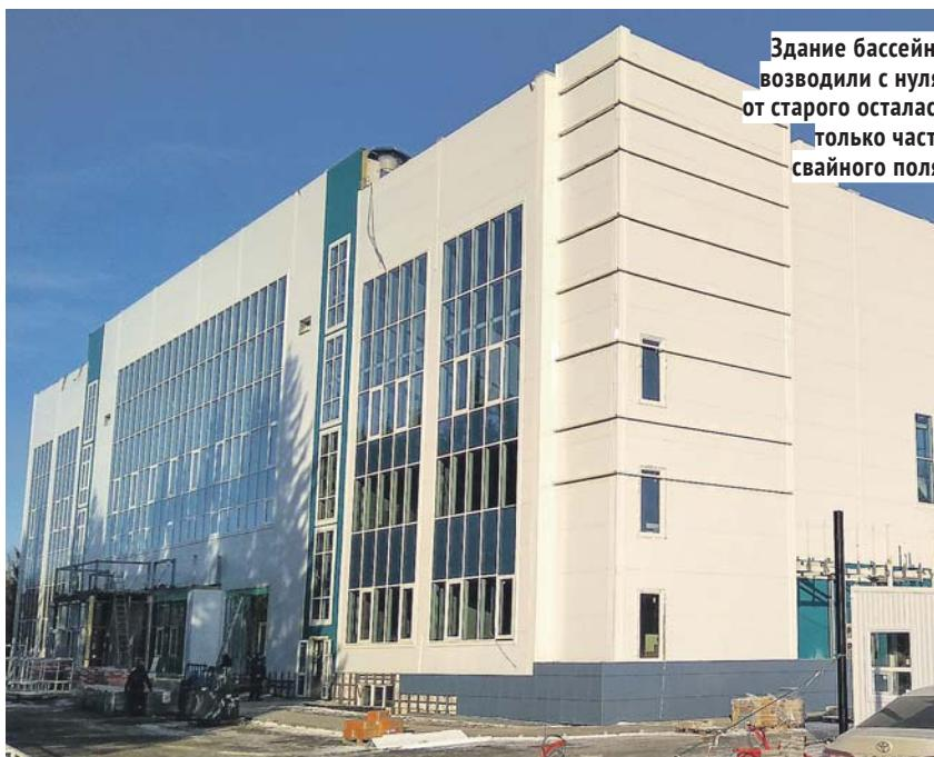
Здание бассейна возводили с нуля, от старого осталась только часть свайного поля.
