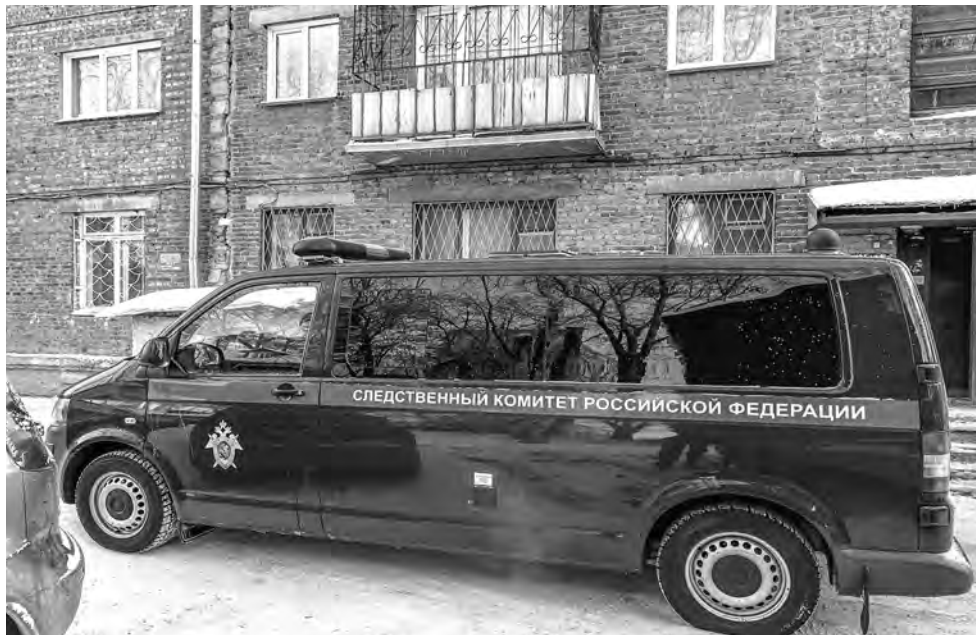
В причинах появления трещины дома на Римского-Корсакова, 10 сегодня разбираются Следственный комитет и прокуратура.
