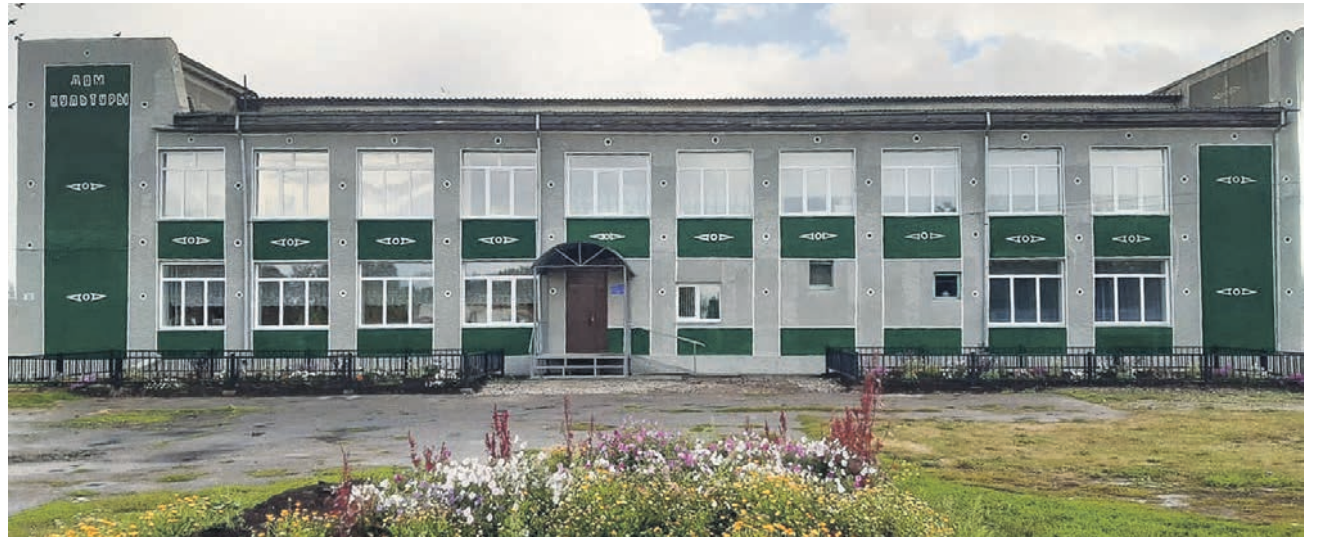
Ремонт фасада клуба в Большеникольском — один из многочисленных социальных объектов этого года.
