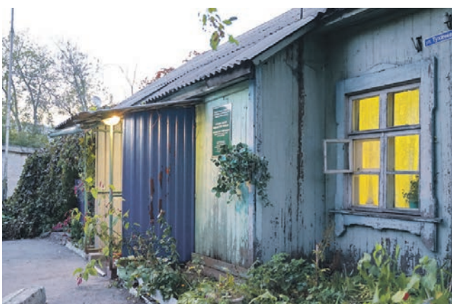
В таких условиях сегодня размещается подстанция скорой помощи района.
