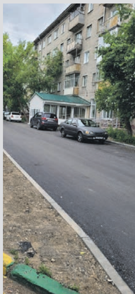
Ремонт асфальтового покрытия у дома по ул. Б. Богаткова, 50 выполнен по наказу избирателей.
