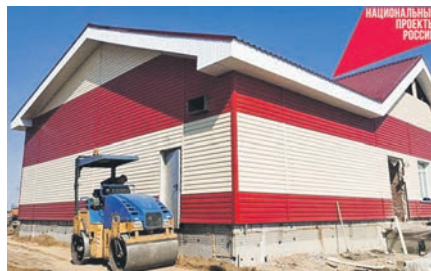
Строительство нового Дома культуры в деревне Весёлый Кут Купинского района.
