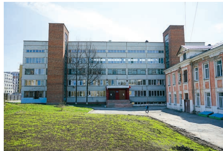
Для школы №32 депутат Дмитрий Макаров добился ремонта кровли.
