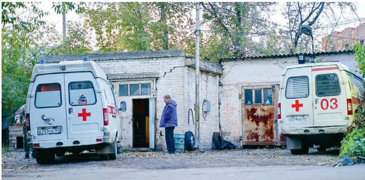
В этом году будет подготовлена ПСД на строительство новой подстанции «Скорой помощи» в Матвеевке.
