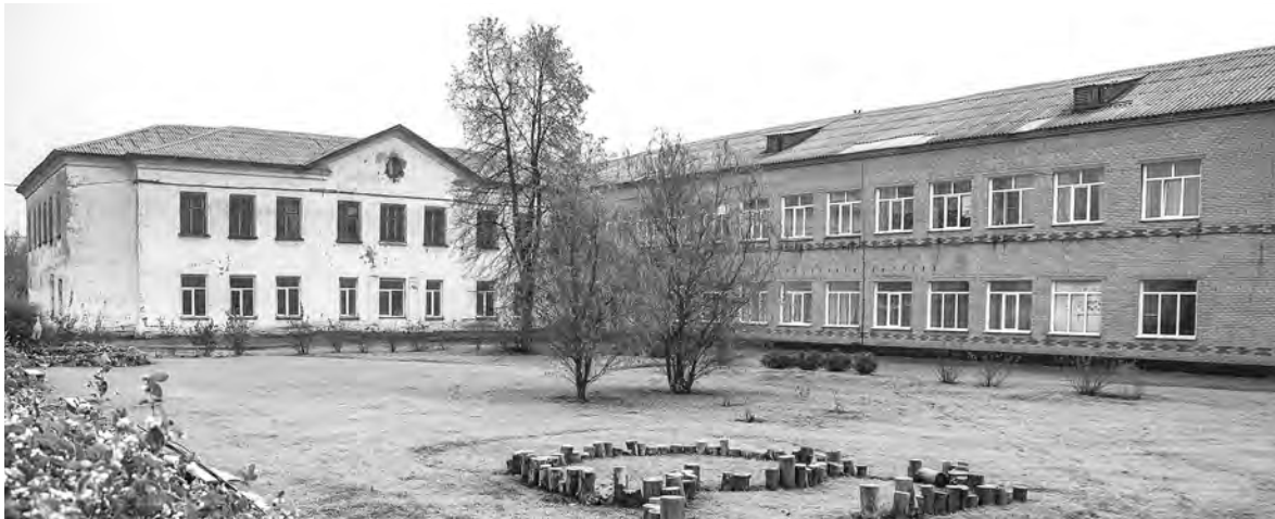
Вместо старого корпуса школы в Посевной уже в следующем году должны начать строительство нового здания.
