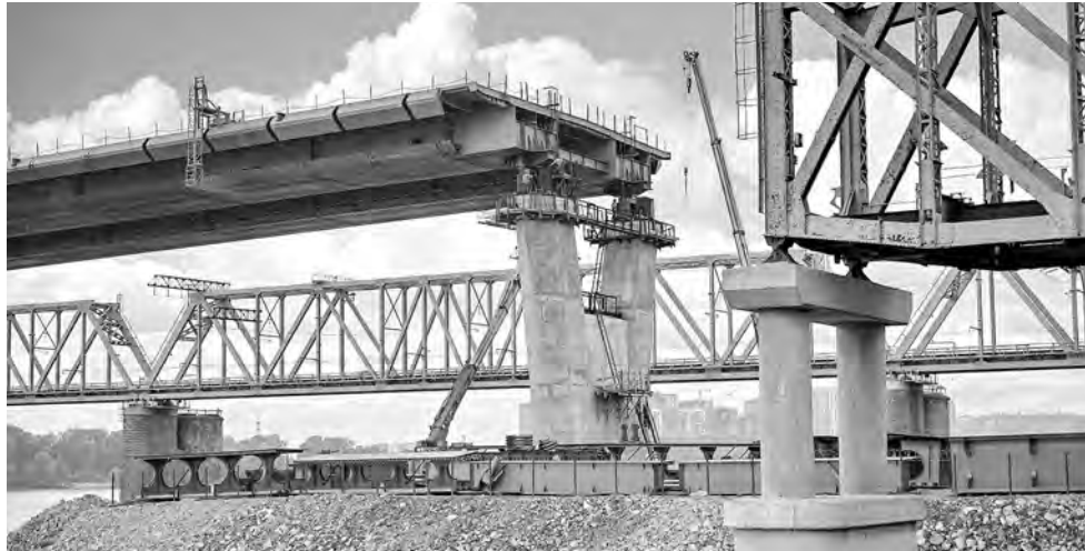
На строительство четвёртого моста через Обь поступит 1 млрд рублей из федерального бюджета.
