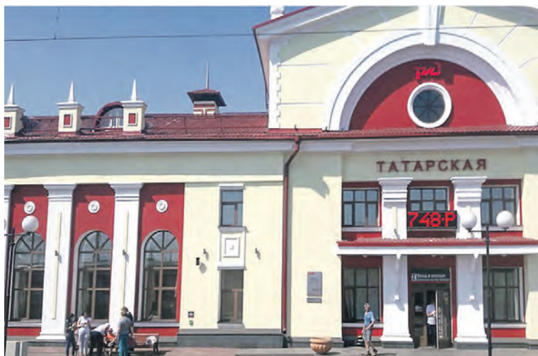
Городской вокзал после масштабной реконструкции в 2020 году.
