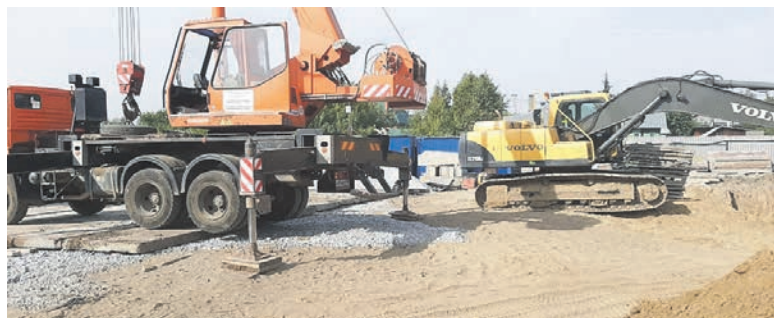
Летом началось строительство поликлиники на улице Ереванская.
