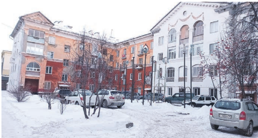
Дома по 1-му и 2-му Краснодонскому переулкам требуют завершения капитального ремонта.
