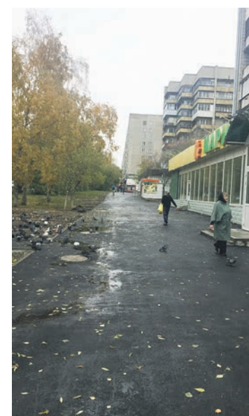
Тротуар у дома №66 по улице Никитина, отремонтированный по наказам избирателей.
