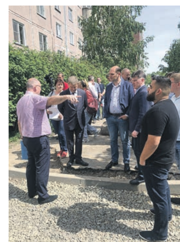
Проверка хода работ по благоустройству у дома №3 по улице Толстого.
