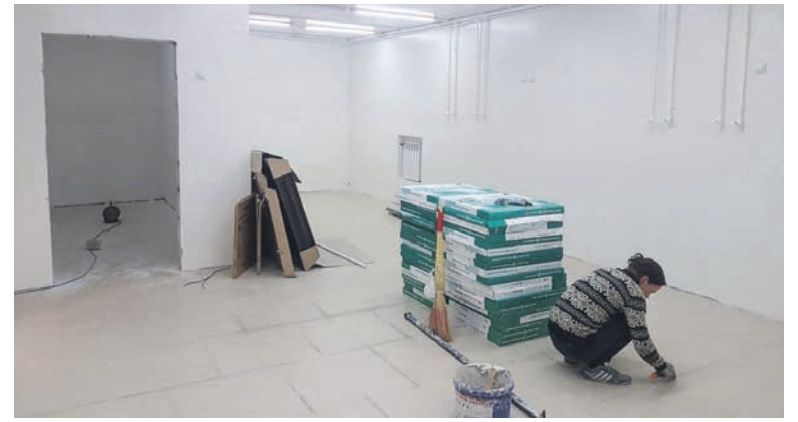
Завершается ремонт здания для купинского лицея №2. Вскоре здесь будут заниматься ученики начальных классов.
