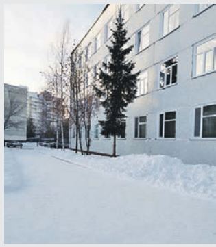
В школе №206 идёт ремонт на средства депутатского фонда.
