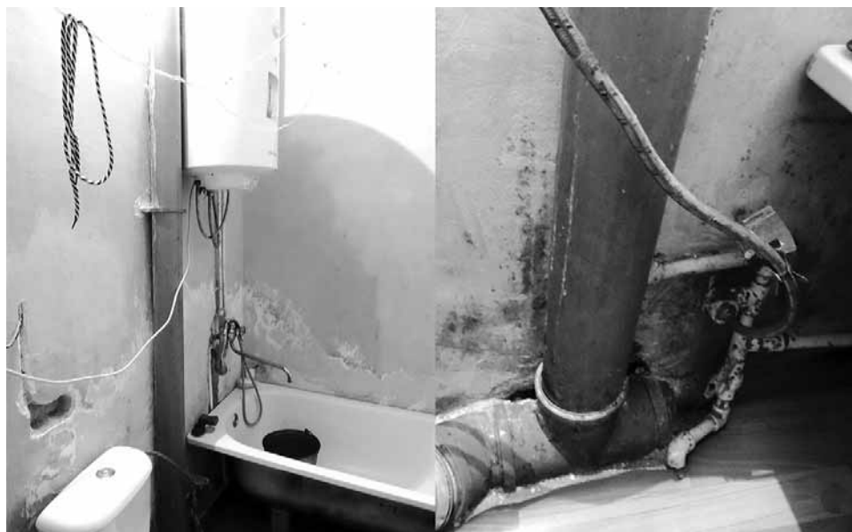
Санузел квартиры № 10 в доме № 25 по ул. Мира в р.п. Колывань.
