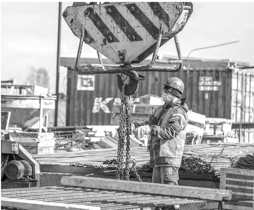
Перевод финансового обеспечения строительных работ на эскроу-счета в 2020 году заработал в полную силу.
