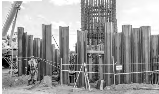
Металлоконструкции для будущего полотна моста.
