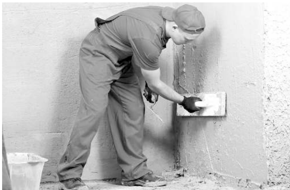
По новому закону ремонтные работы нельзя будет вести с 22:00 до 7:00.
