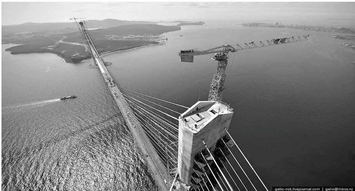
Остров Русский. Строительство вантового моста.
