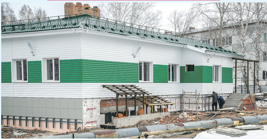
Полным ходом идёт строительство врачебной амбулатории в Дорогино.
