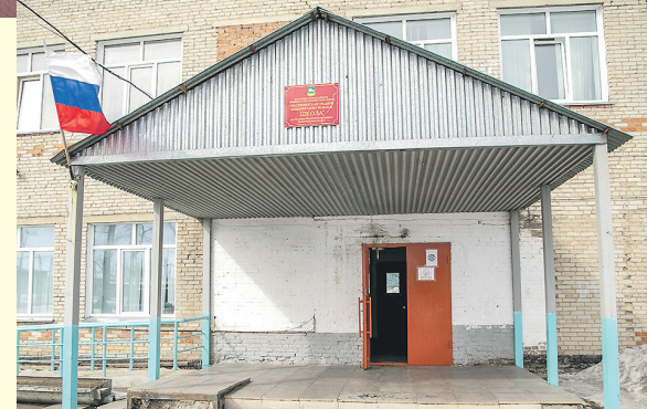
В Посевнинской школе по наказам отремонтирована крыша.
