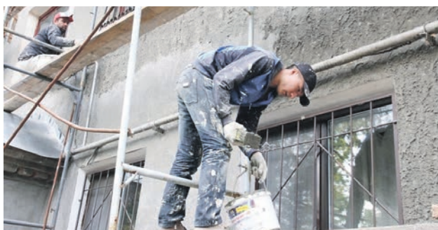
Обновился фасад здания старого корпуса городской клинической больницы №12 (ул.Трикожанная, 49/1). Там же отремонтировано помещение приёмного отделения. Общая стоимость выполненных работ – 9 миллионов рублей.
