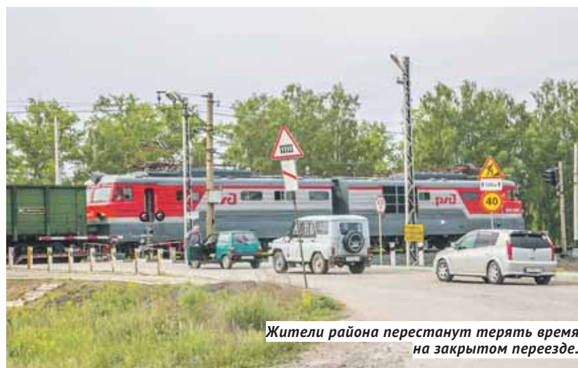
Виадук через Транссиб должен быть достроен в этом году.
