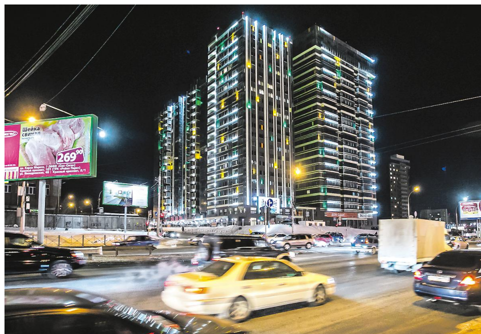
Покупатели жилья в долгострое по улице Военной дождались своих квартир.
