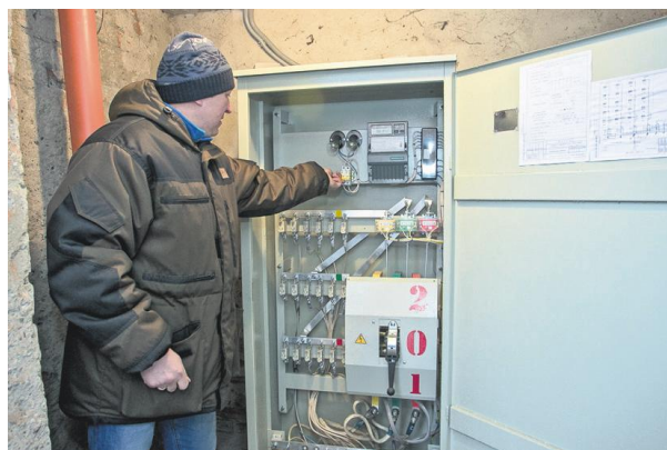
Одна из главных задач при проведении капремонта — замена всех систем жизнеобеспечения дома.
