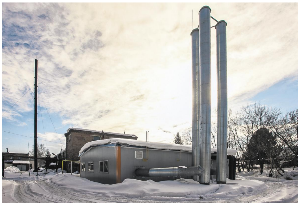
В 2014 году была введена в эксплуатацию центральная газовая котельная рабочего посёлка Маслянино. В стадии завершения — газификация других населённых пунктов района.
